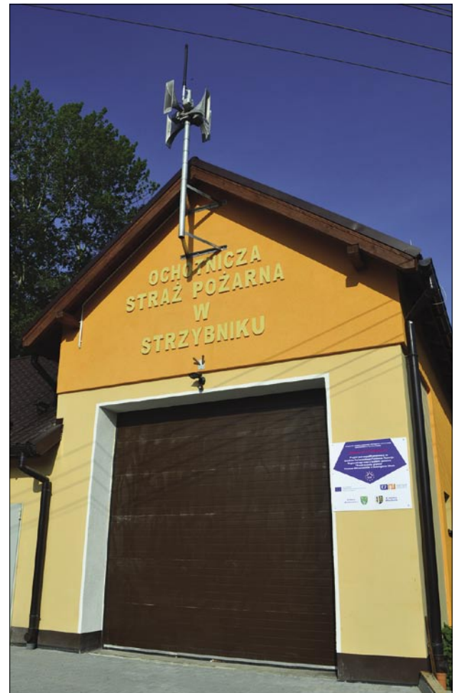
SÍRENA VČASNÉHO VAROVÁNÍ NA BUDOVĚ HASIČSKÉ ZBRONICE SDH VE STRZYBNIKU. PROJEKT OBCE RUDNIK – BEZPEČNÉ PŘÍHRANIČÍ
